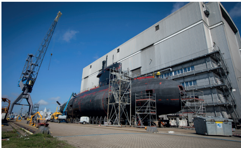
Werkzaamheden ten behoeve van de Instandhoudingsgroep Onderzeedienst van het DMI.
